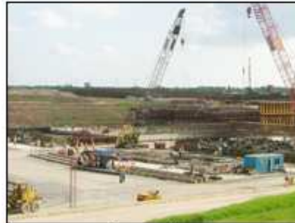
Công trình bê đúc hầm Thủ Thiêm nằm sâu dưới đất - Ảnh Ngọc Hậu
